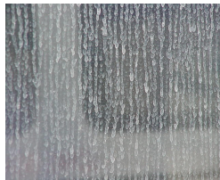
F.1.2.1.1.1 Stage II corrosion
